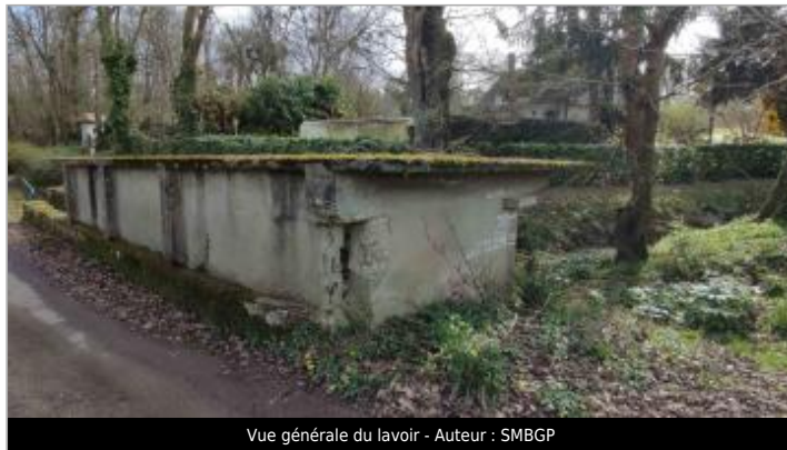
Vue générale du lavoir - Auteur : SMBGP
