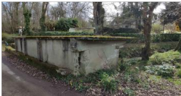
Vue générale du lavoir - Auteur : SMBGP
