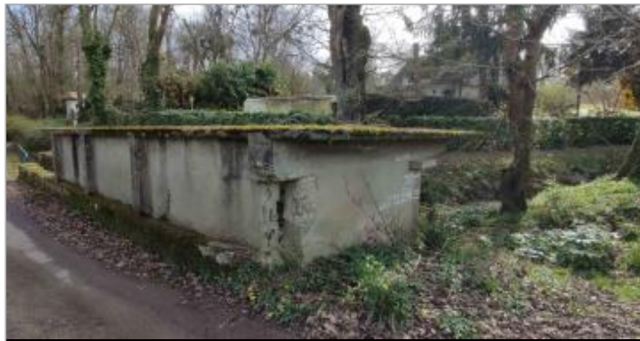
Vue générale du lavoir - Auteur : SMBGP
