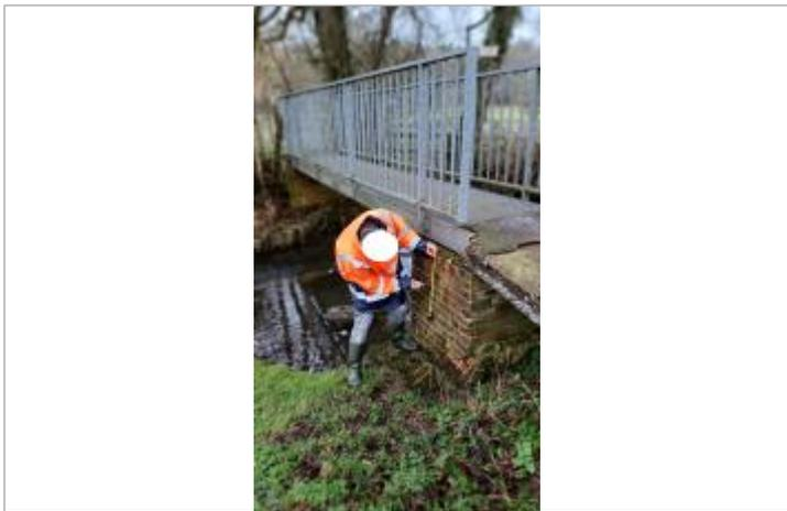
Laisse de crue sur le pilier en briques, rive droite, à 20 cm au dessous de la base du plancher de la passerelle.
