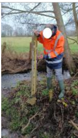
Laisse de crue sur le poteau en ciment de clôture à 1 m/sol.
