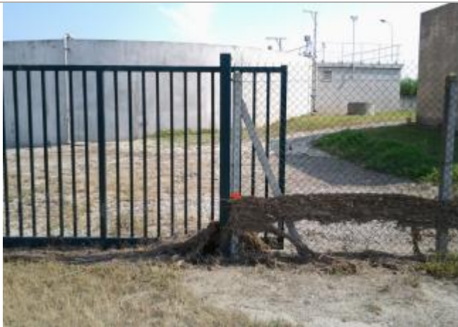
Vue du repère (laisse de crue visible) - Auteur : HEA/DDTM 64
