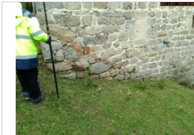
Vue du repère rapprochée en 2021
