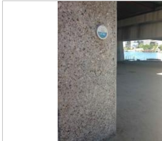
Repère de crue sur la pile aval du pont de Sèvres
