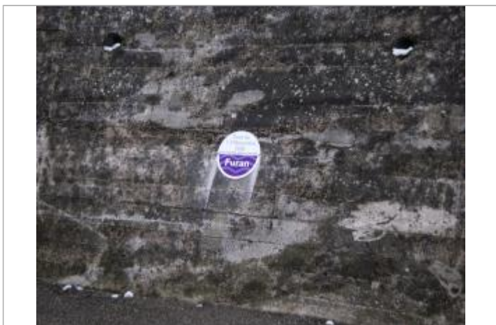
Vue rapprochée du repère en 2022
