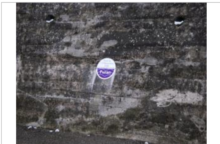
Vue rapprochée du repère en 2022
