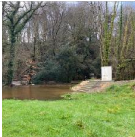
Station limnimétrique de l'Odet à Tréodet
