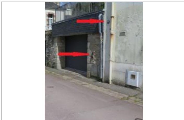
Mur du bâtiment au 8 place Lovignon
