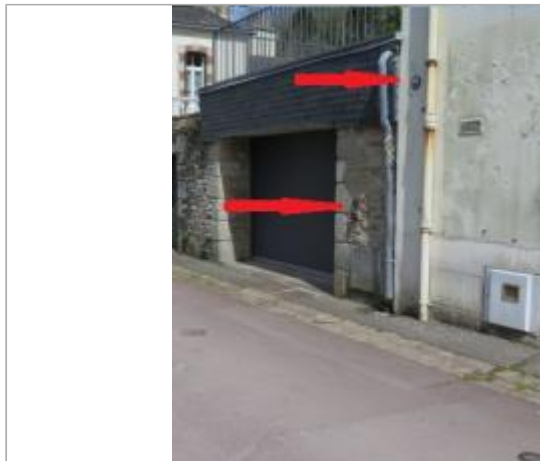
Mur du bâtiment au 8 place Lovignon
