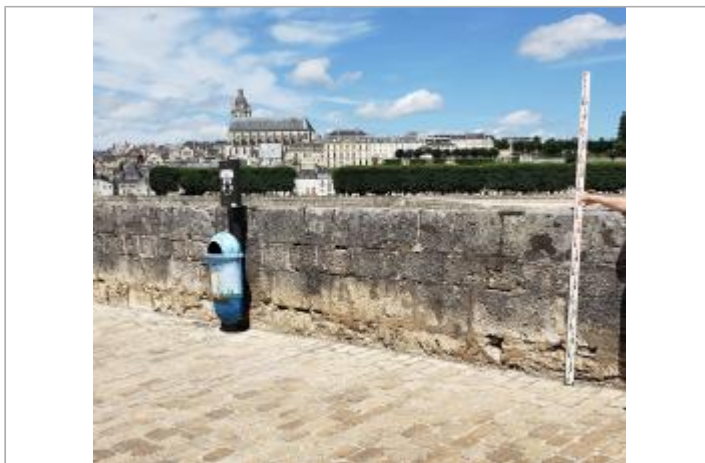
Vue du site en 2022 (auteur du cliché : Alex Campillo)
