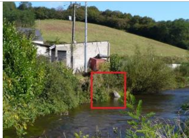
Ancienne station limnimétrique du Jet à Ergué-Gabéric (Meil-Jet)
