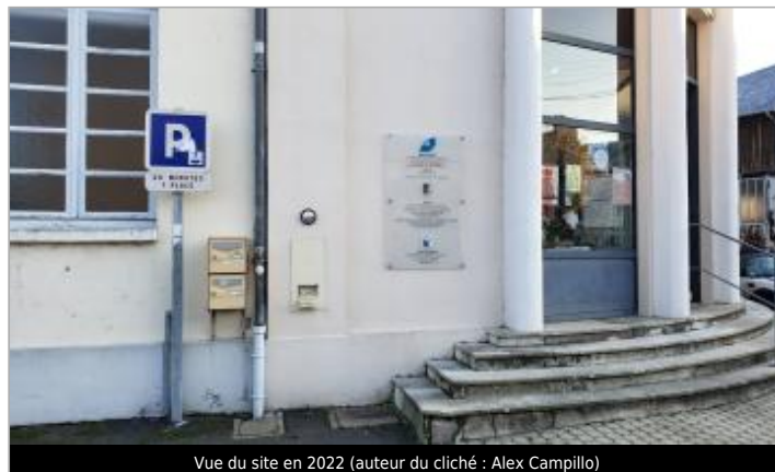
Vue du site en 2022 (auteur du cliché : Alex Campillo)
