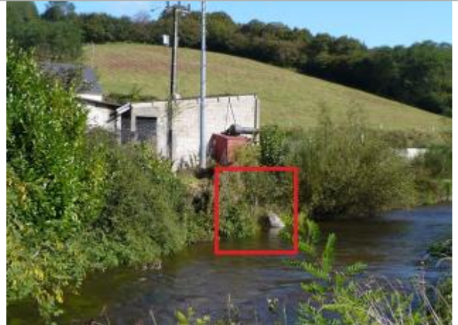
Ancienne station limnimétrique du Jet à Ergué-Gabéric (Meil-Jet)
