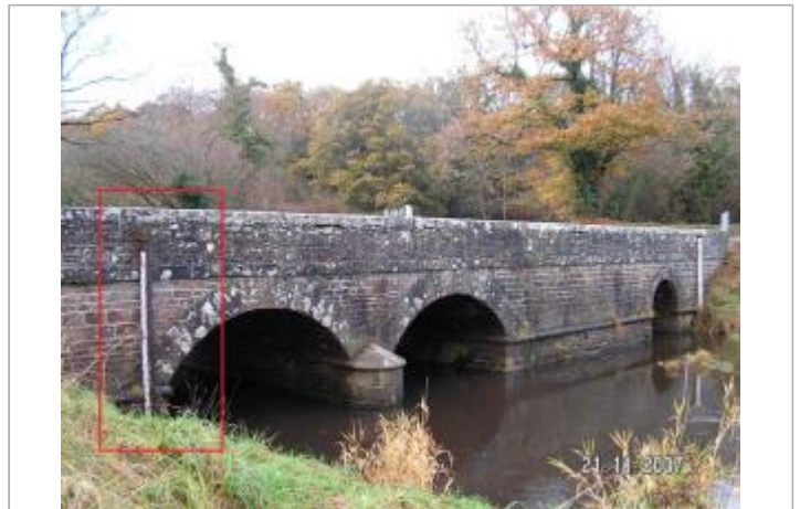
Station limnimétrique de l'Odet à Ergué-Gabéric (Kersaviou)
