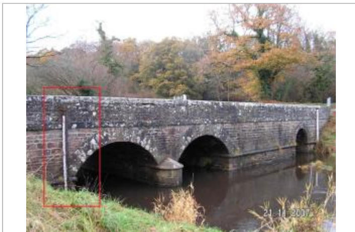
Station limnimétrique de l'Odet à Ergué-Gabéric (Kersaviou)
