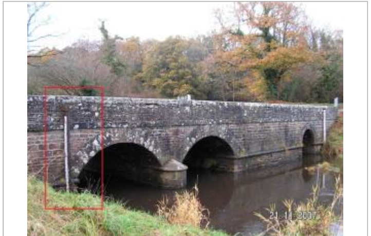
Station limnimétrique de l'Odet à Ergué-Gabéric (Kersaviou)
