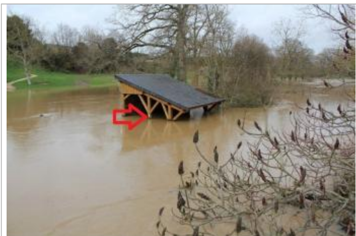
niveau d'eau en-dessous des arches du lavoir
