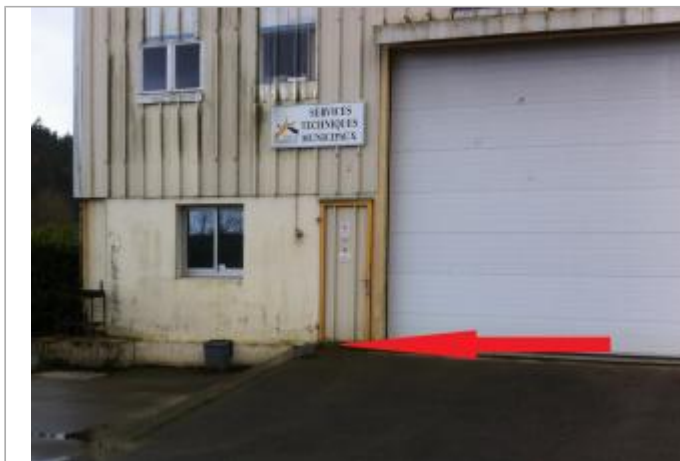
Bâtiment des services techniques, rocade de Parc Bihan
