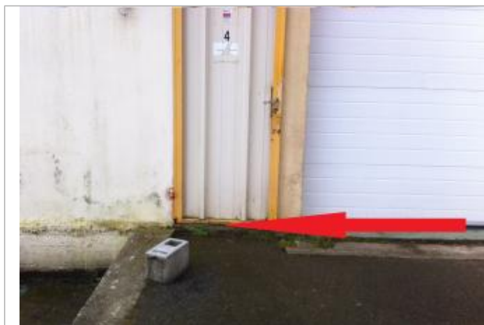
Bâtiment des services techniques, rocade de Parc Bihan (885993)
