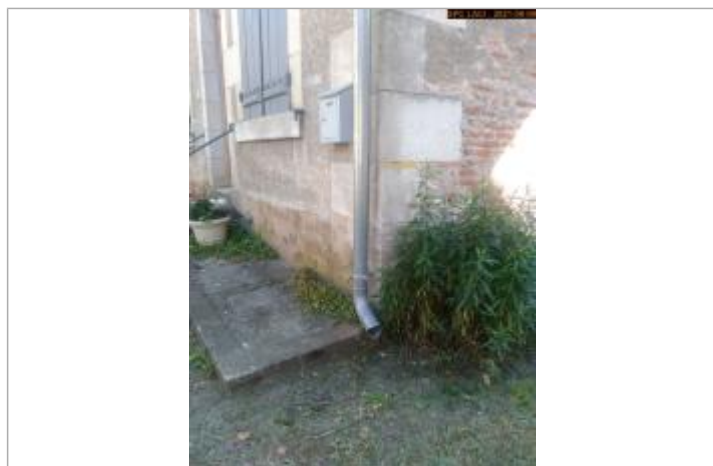
Vue du repère rapprochée en 2021
