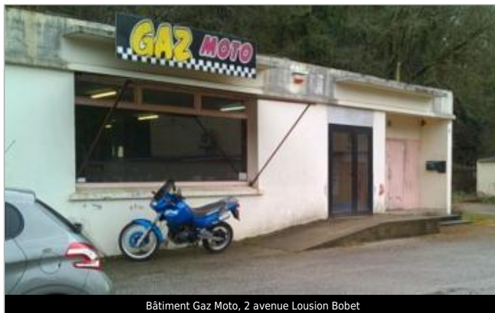
Bâtiment Gaz Moto, 2 avenue Lousion Bobet
