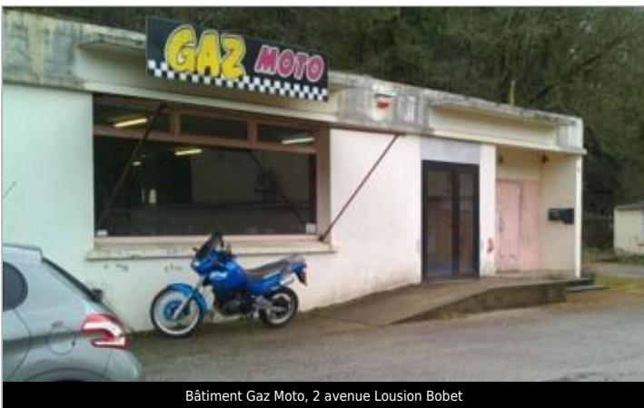
Bâtiment Gaz Moto, 2 avenue Lousion Bobet
