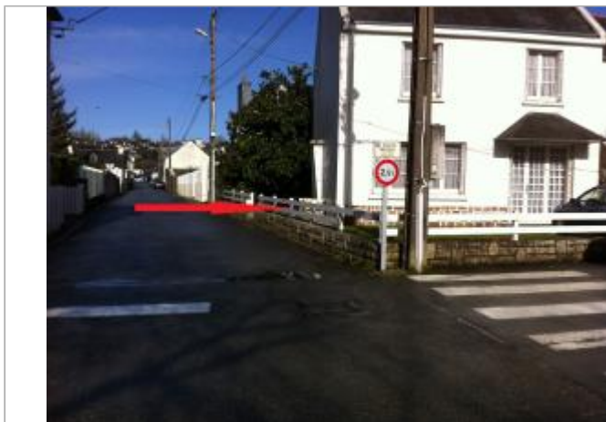
bâtiment au 39 quai Robert Alba
