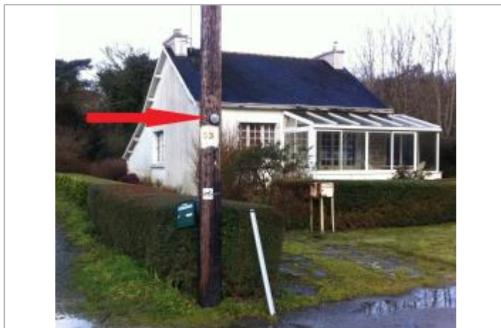
Bas du poteau en bois, route de Coatigaor
