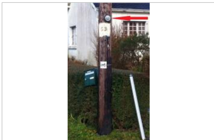
Repère normalisé de la crue de Décembre 2000
