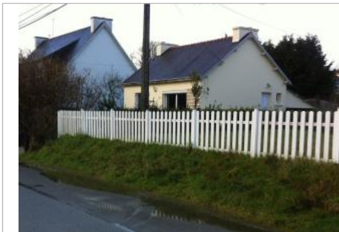
Bâtiment au 51B quai Robert Alba
