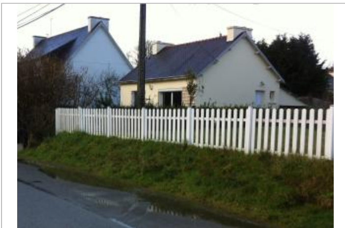
Bâtiment au 51B quai Robert Alba
