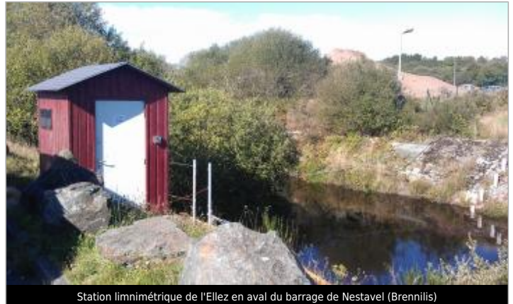
Station limnimétrique de l'Ellez en aval du barrage de Nestavel (Brennilis)
