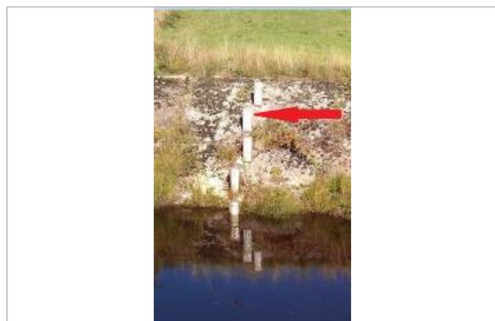
Echelle limnimétrique de l'Ellez en aval du barrage de Nestavel (Brennilis)
