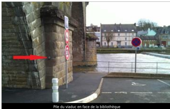
Pile du viaduc en face de la bibliothèque
