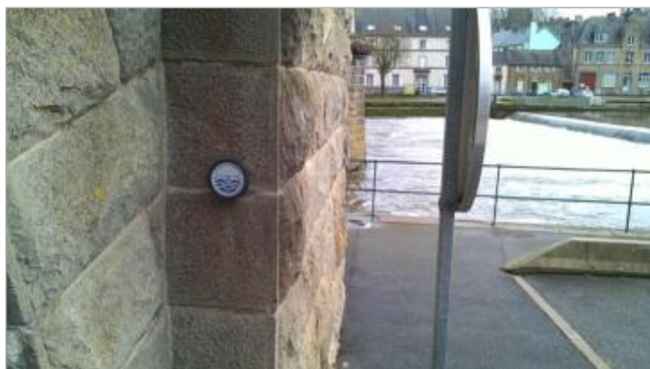
Repère normalisé de la crue de Décembre 2000
