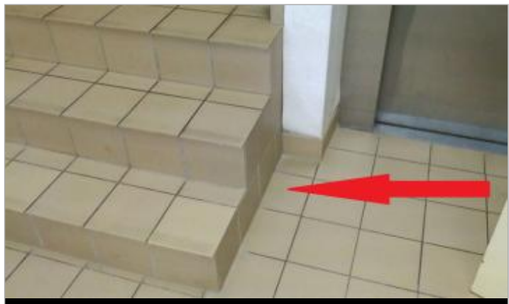
Niveau d'eau en-dessous de la première marche
