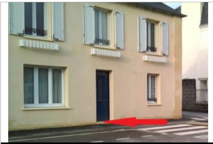
Bâtiment au 17 quai Robert Alba
