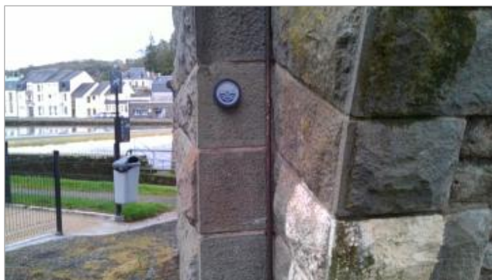
Repère normalisé de la crue de Décembre 2000
