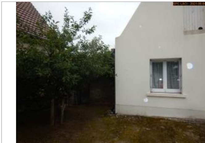
Vue du site en 2021 : crue 06/1856
