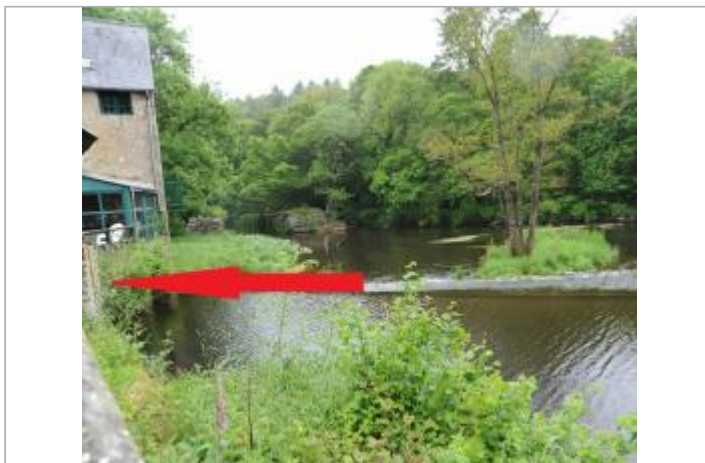
Station limnimétrique de l'Aulne à Pont-Triffen
