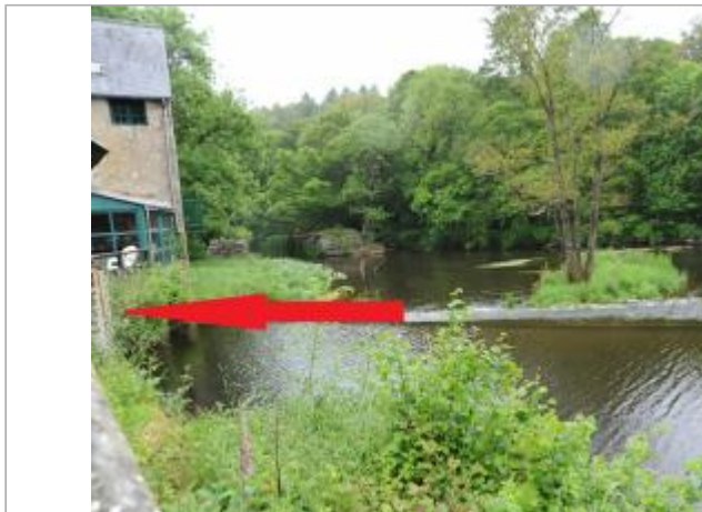
Station limnimétrique de l'Aulne à Pont-Triffen
