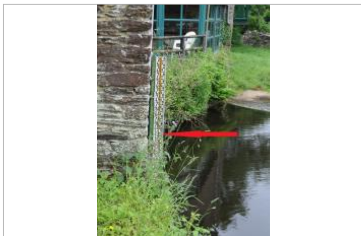
Echelle limnimétrique de l'Aulne à Pont-Triffen
