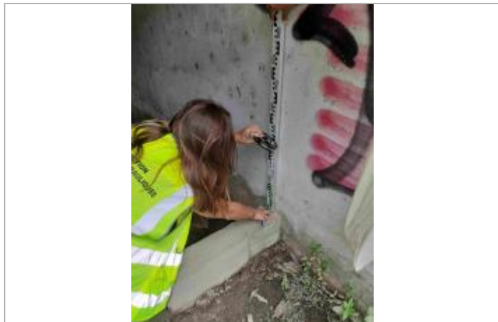
Niveau mesuré depuis un rebord béton sous le bâtiment
