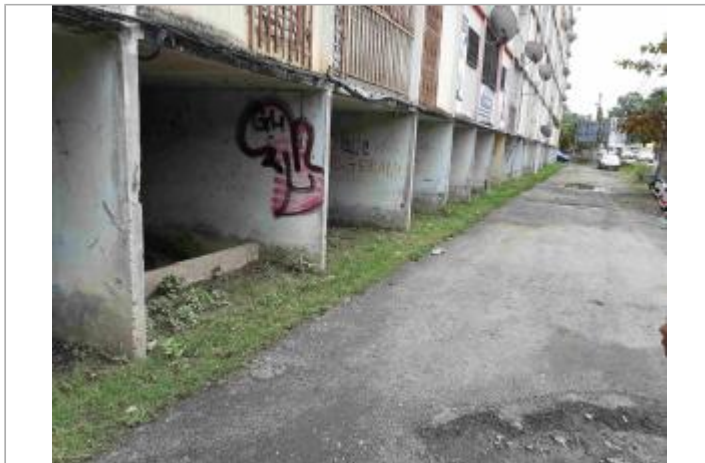
Immeuble - Route de Chauvel
