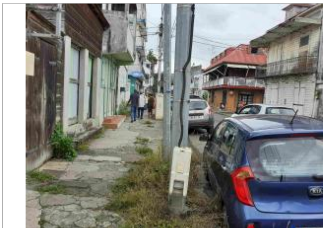
Voiture garée sur la chaussée (rue vatable)
