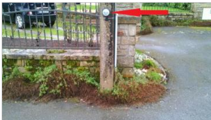
Repère normalisé de la crue du 13 décembre 2000
