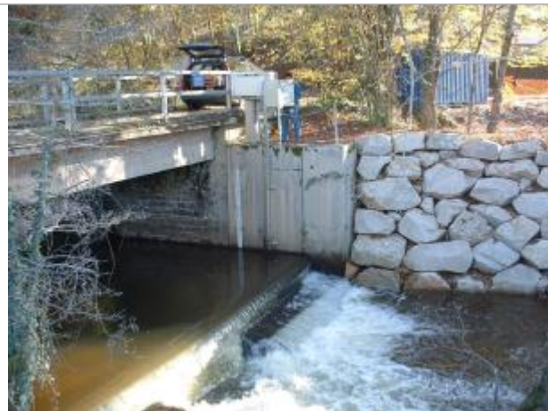
Station limnimétrique de l'Aulne à Poullaouen - Le Goask
