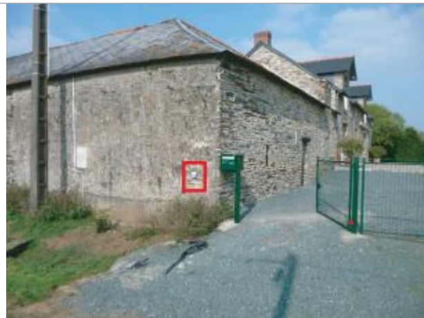
Maison Individuelle, La Tremblais
