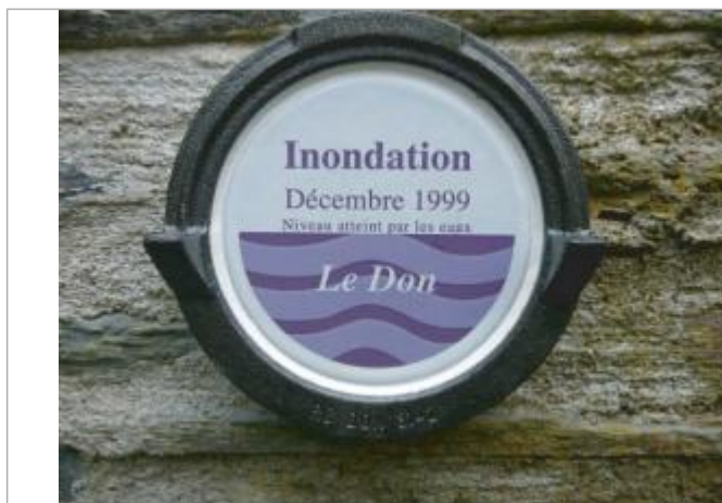
Repère normalisé de la crue de Décembre 1999
