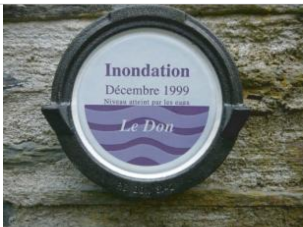
Repère normalisé de la crue de Décembre 1999
