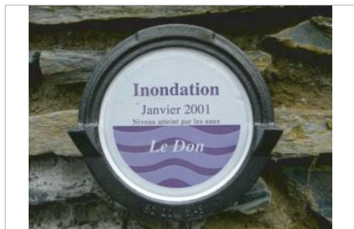
Repère normalisé de la crue de Janvier 2001
