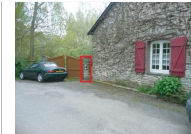
Maison Individuelle, le pont des claies
