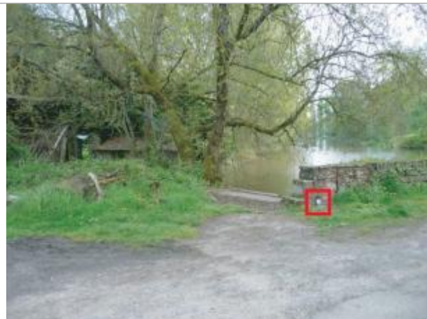
Muret à la rue du Grand Moulin
