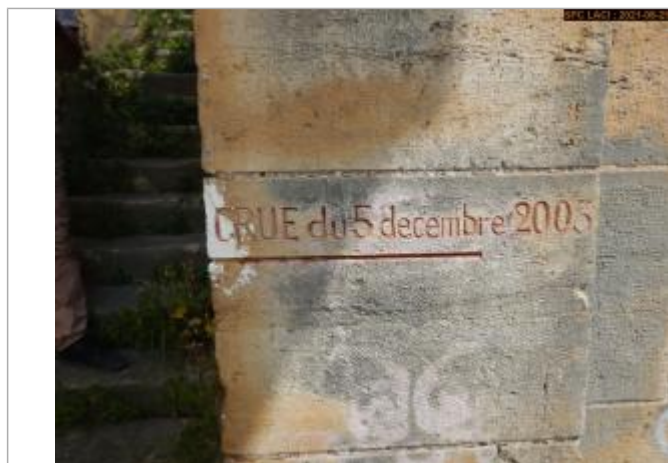
Vue du repère rapprochée
