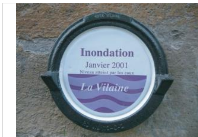
repère normalisé de la crue de janvier 2001
