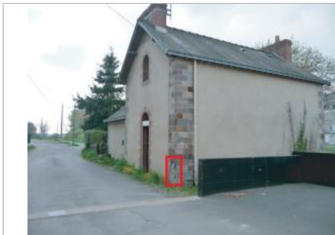
Maison individuelle, 5 rue de la Vilaine
