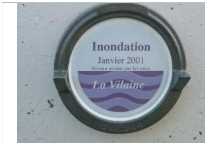
Repère normalisé de la crue de janvier 2001
