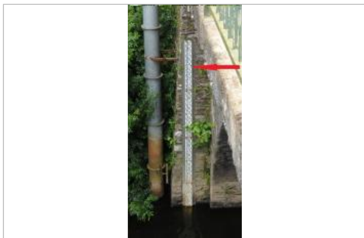
Echelle limnimétrique de l'Aulne à Chateauneuf-du-Faou
