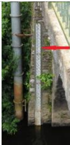
Echelle limnimétrique de l'Aulne à Chateauneuf-du-Faou
