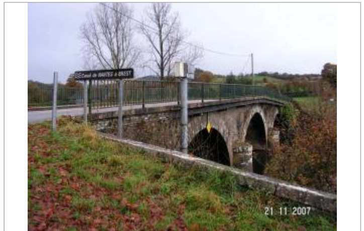
Station limnimétrique de l'Aulne à Chateauf-neuf-du-Faou
